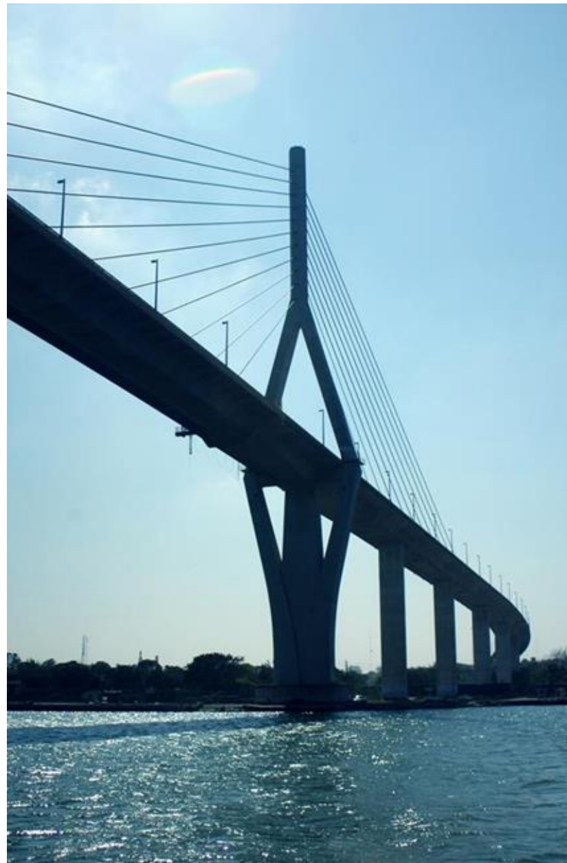
Puente del Río Pánuco, Tampico Tamaulipas.
